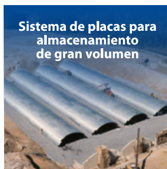
Sistema de infiltración CMP perforado
